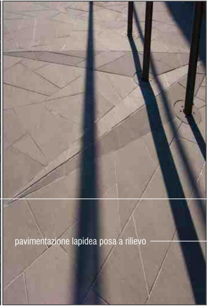
pavimentazione lapidea posa a rilievo
