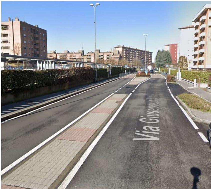
*riserva centrale semisormontabile con inserimento di isole insormontabili a protezione dell'attraversamento pedonale*
